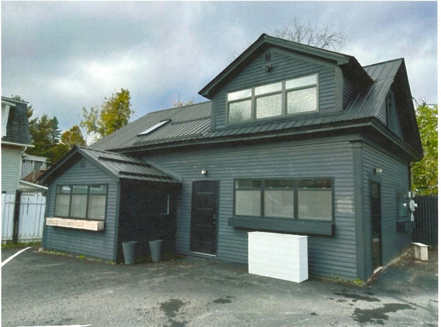
East (facing Smythe Street) / Est (face à la rue
